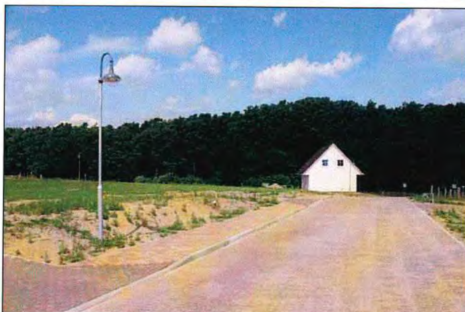
Menz-West: Erstes Gebäude im 1. Bauabschnitt
