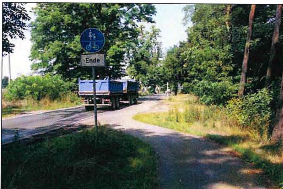
Menz Ortsdurchfahrten der Landesstraßen Oben und Mitte: Fehlende Querungsmöglichkeiten; Unten: Vorzeitiges Ende der Geh- und Radweges an der Berliner Straße
