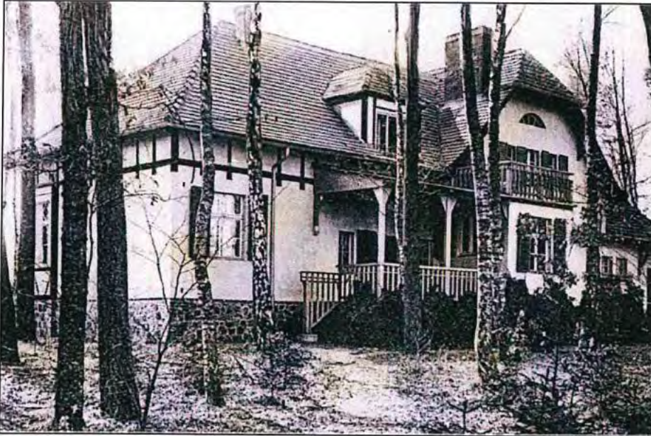
Neuglobsow Haus Labes an der Stechlinseestraße, Fassade Zustand vor 1945 Archiv J. Graetz
