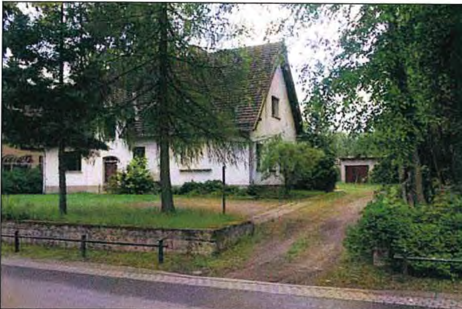
Neuglobsow Ehemalige Schule an der Stechlinseestraße Fassade heute stark vereinfacht
