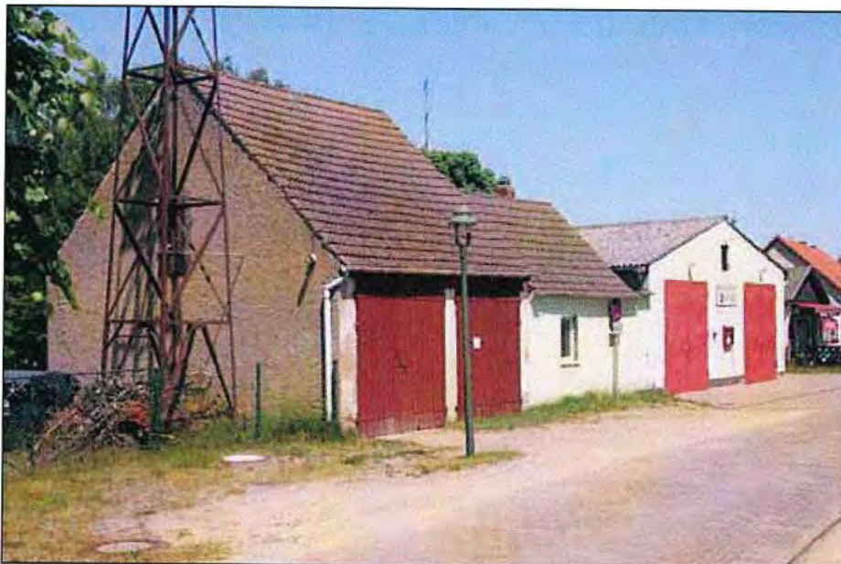
Menz Abstellgebäude neben der Feuerwehr
