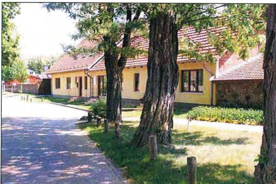
Menz Oben: Alte Schule Unten: Privatisierte ehemalige Nebengebäude der Schule
