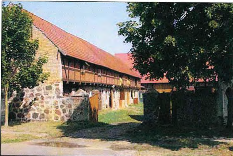
Dollgow, Saniertes Stallgebäude an der Dorfstraße
