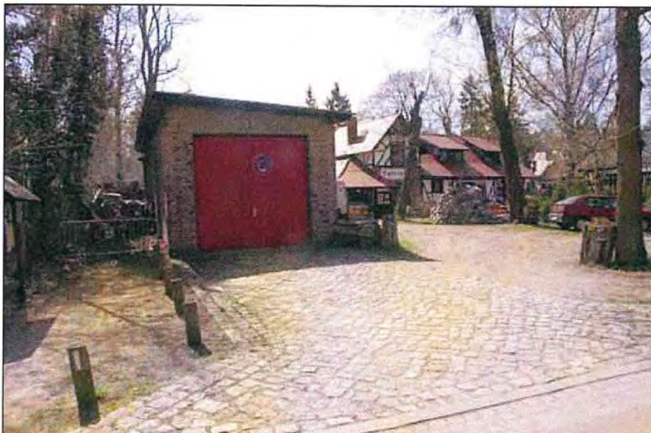
Neuglobsow Ehem. Feuerwehrgerätehaus
