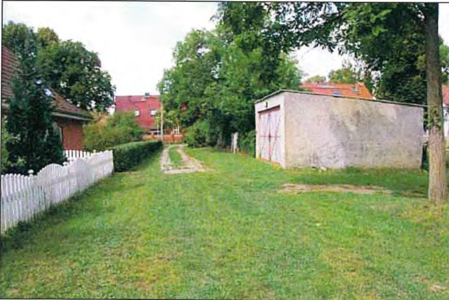
Dollgow Gerätehaus der Feuerwehr
